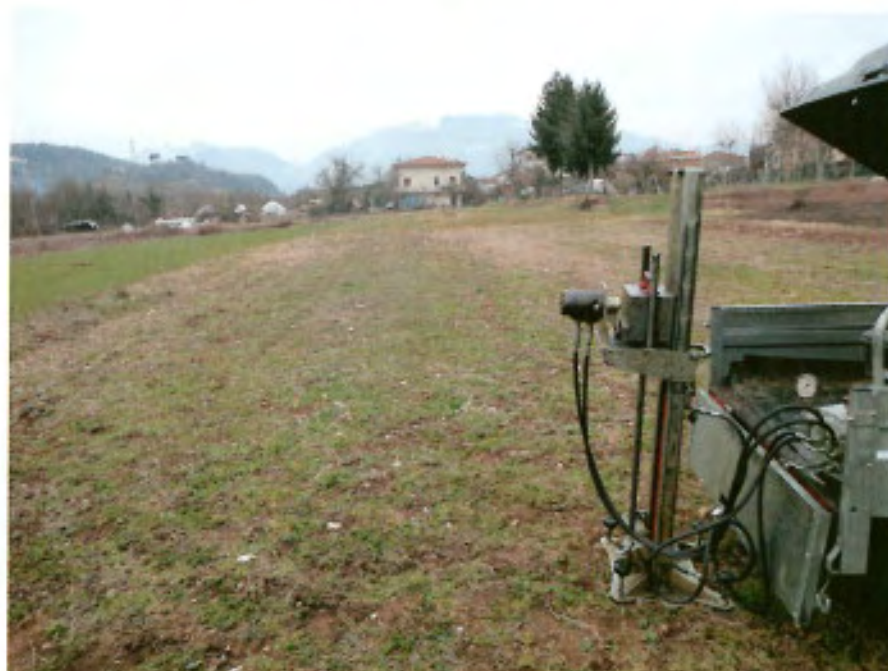
foto 2 – Esecuzione della prova penetrometrica PDM 5.
